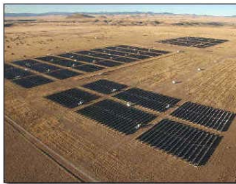
Centrale de Springerville
