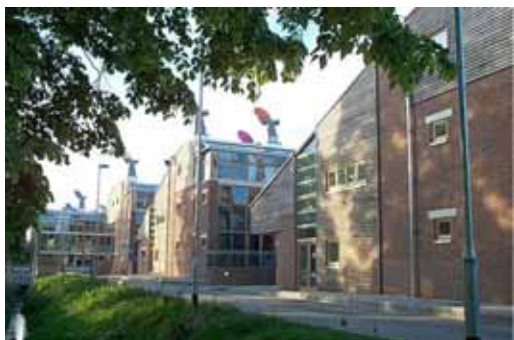
BedZED, vue du village de Beddington
