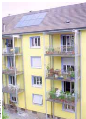
Maison familiale des années 30 rénovée. Système solaire thermique intégré en toiture
